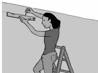
III. Entfernen Sie den Schutzfilm vom selbstklebenden Montageband auf der Rückseite des ersten Wandpaneels. Das Wandpaneel leicht angewinkelt haltend, kleben Sie die obere Längskante des Wandpaneels an die Wand und klappen Sie dann das Wandpaneel herunter. Drücken Sie das Wandpaneel danach für 10 Sekunden händisch an.
