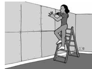
c) Les supports en bois et en matériaux dérivés du bois doivent être poncés avant le montage (grain de 80).
